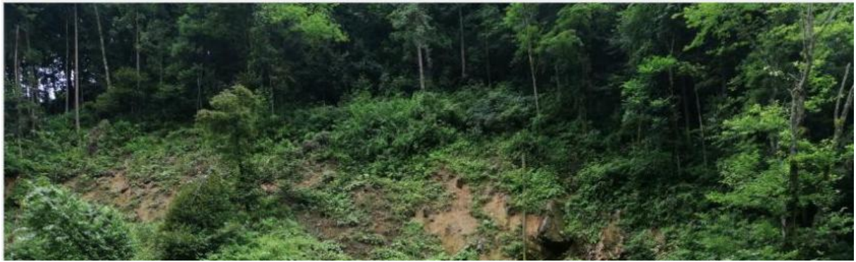
弃渣场现状照片
