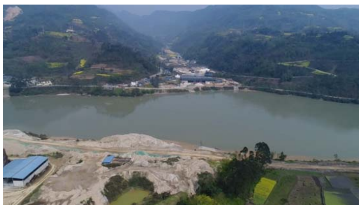
图 1-8 桥位大渡河现状照片
