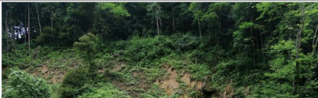
弃渣场现状照片
