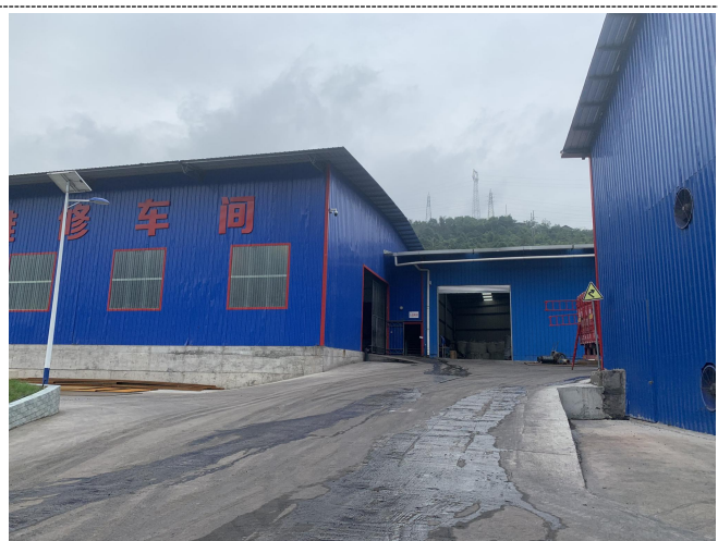
本项目东北面四川恒业硅业有限公司厂房
