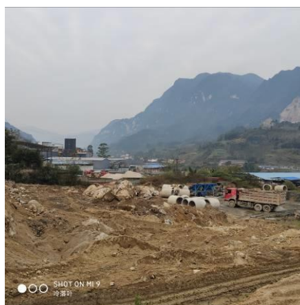
项目拟建地块现状02
