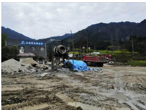
项目拟建地块现状01
