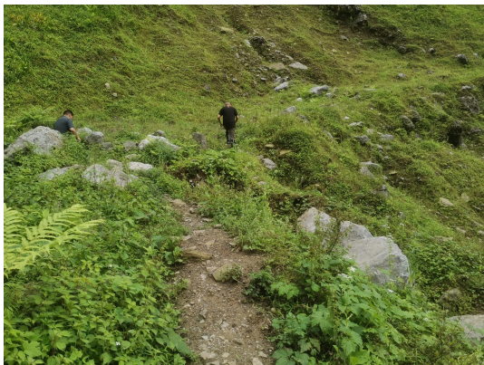
矿山公路垮塌段
