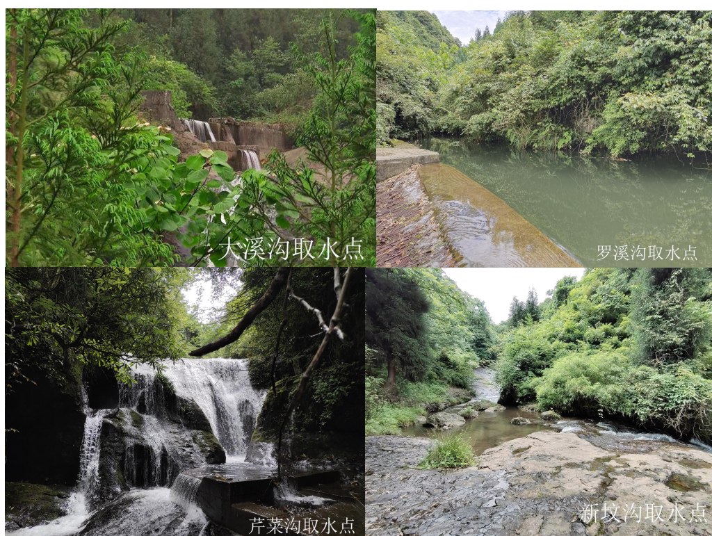
图 3-1 水源现状照片
