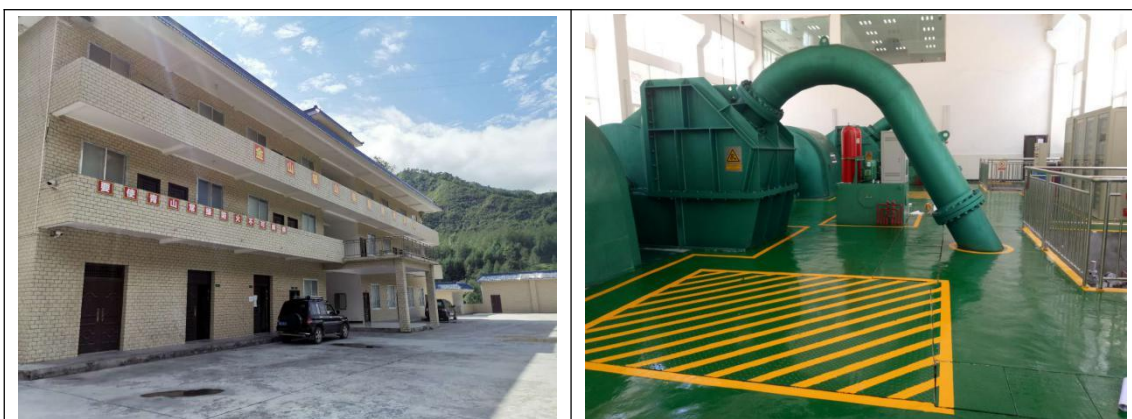
项目厂区枢纽现状
