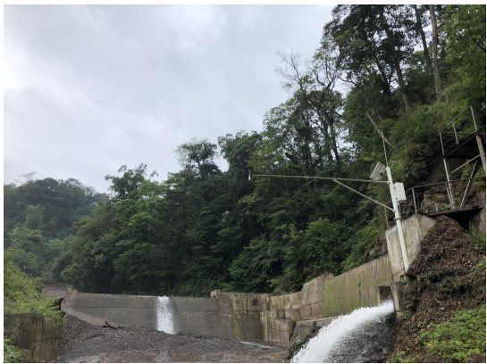
长滩河取水口及下泄流量监控装置
