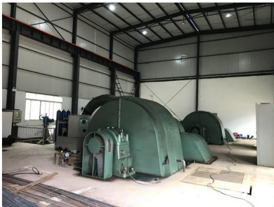
电站水轮发电机组
