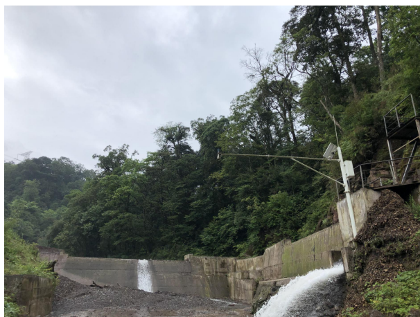
长滩河取水口及下泄流量监控装置
