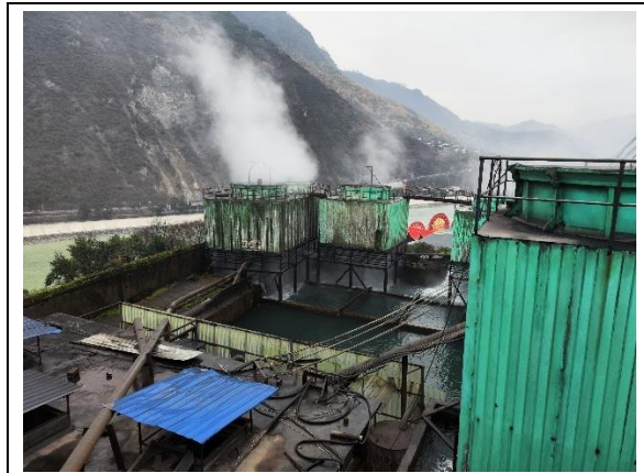
冷却循环水池及冷却塔现状照
