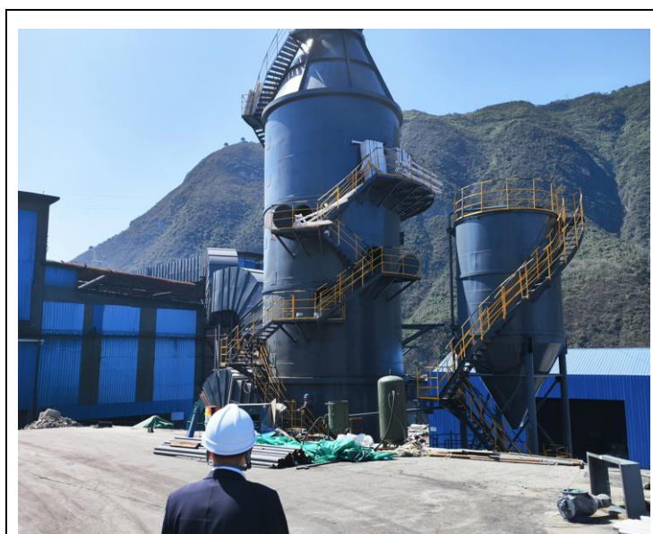
在建脱硫设施
