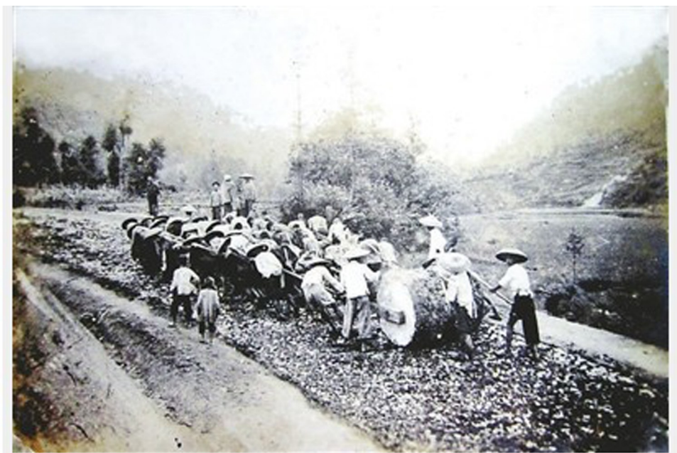
▲修築樂西公路時碾壓路面場景
