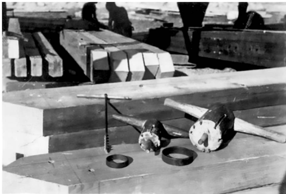
自制开口钢圈及工具
