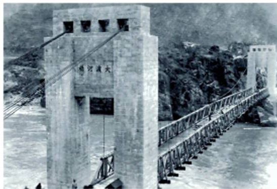
石棉大渡河桥(时为国内第二座最大的悬索桥)
