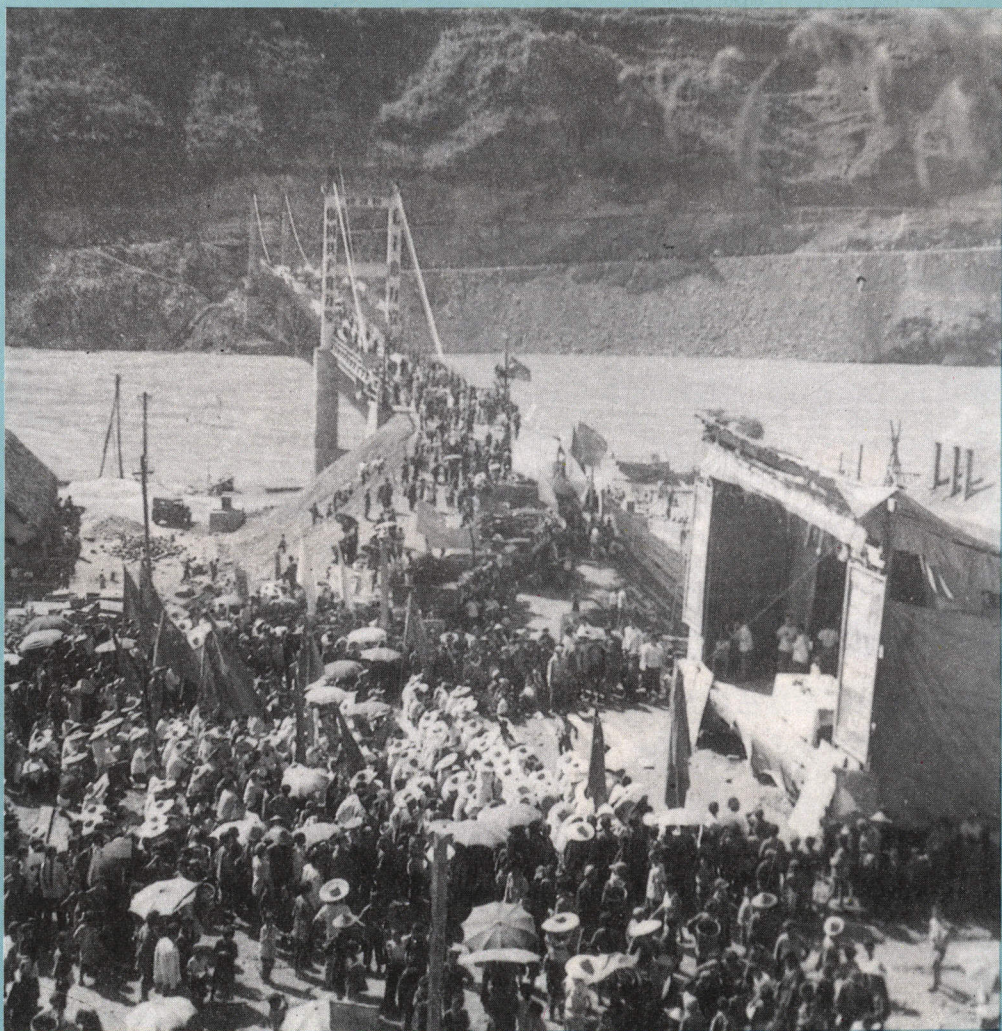
▽ 峨边大桥建成,改善了大渡河两岸的交通条件
